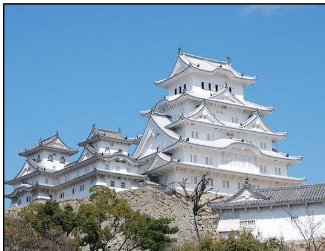
平成の大修理（白すぎ城？）
